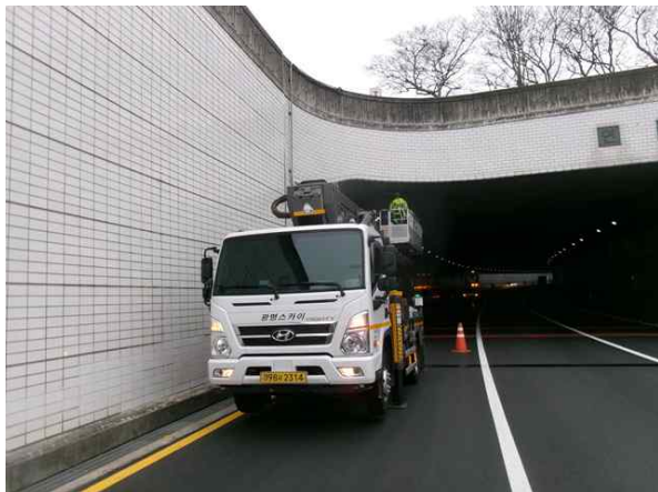
고소점검차를 이용한 근접조사
